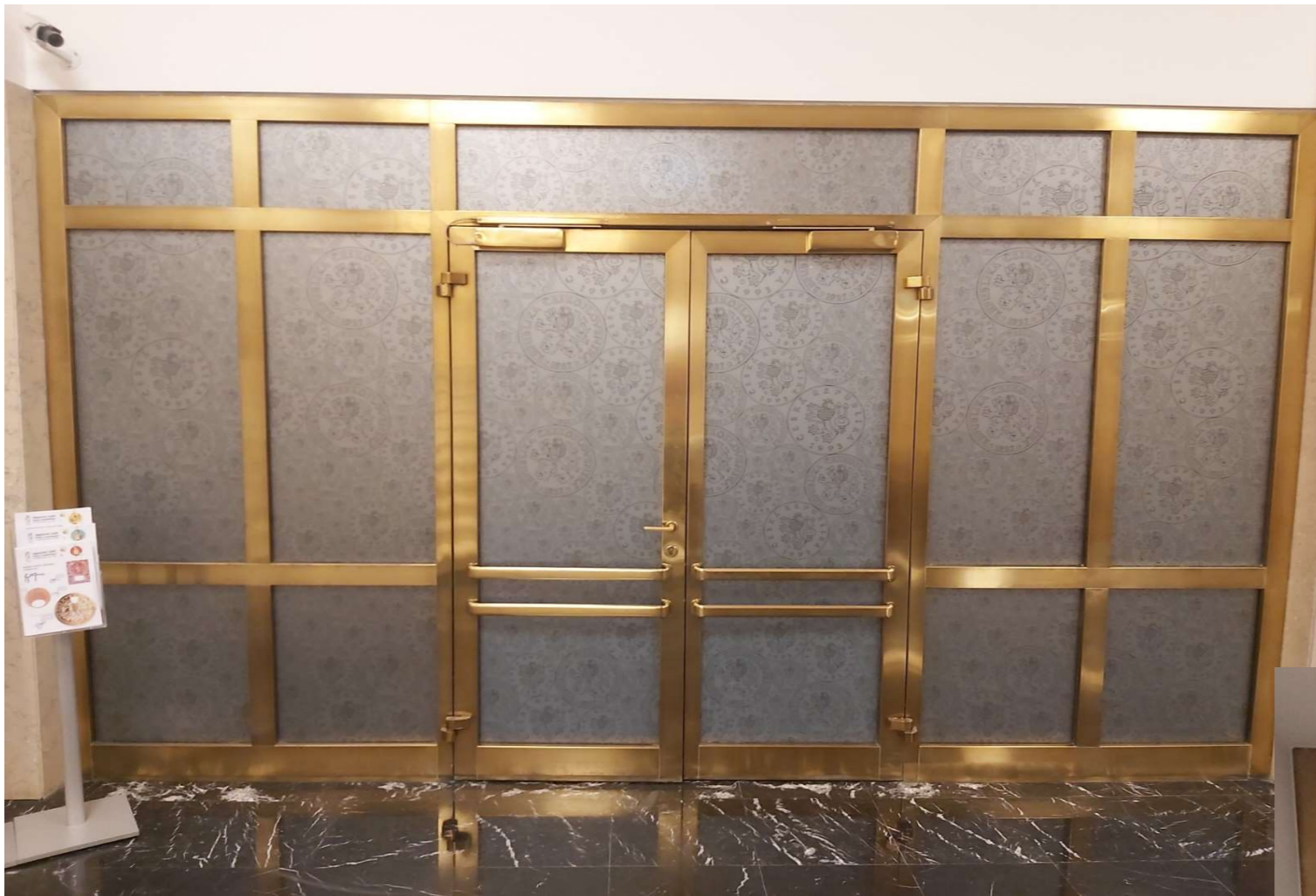
Sestava s dveřmi "Sál" Foto stávajícího stavu
