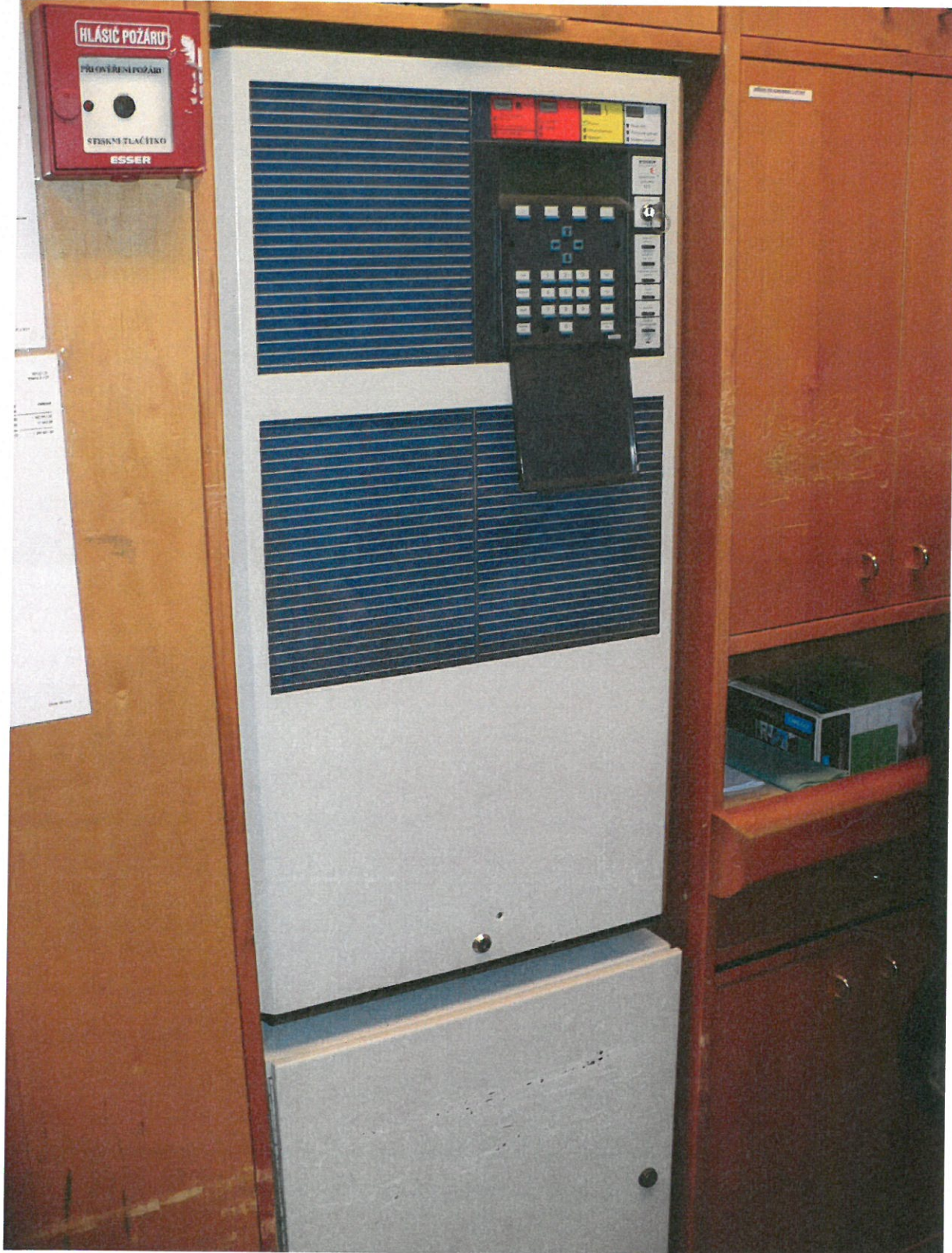
Obr. Umístění ústředny v MP312 Ústředna je umístěna v nábytkové stěně o rozměrech šířka/ výška/ hloubka 50/ 150/ 35 cm
