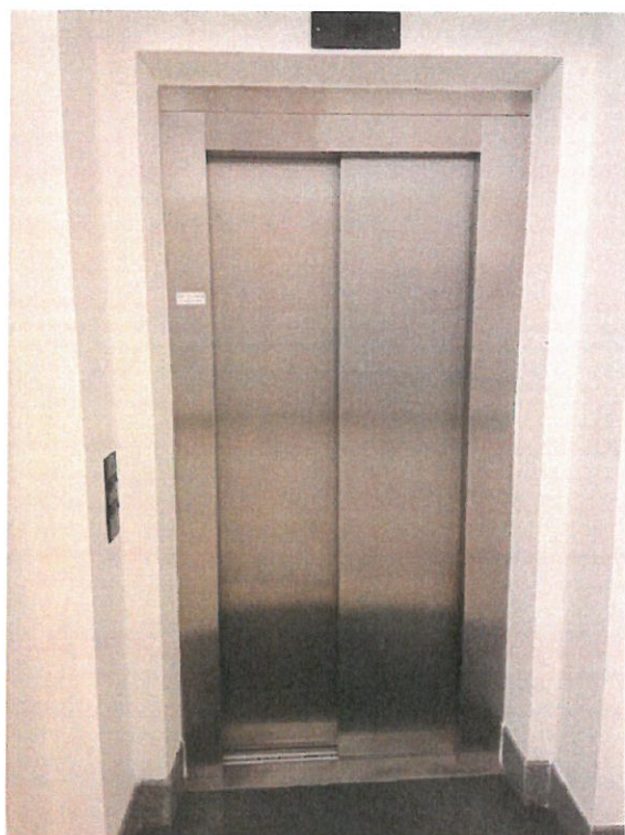
Pohled na dveře ve stanici
