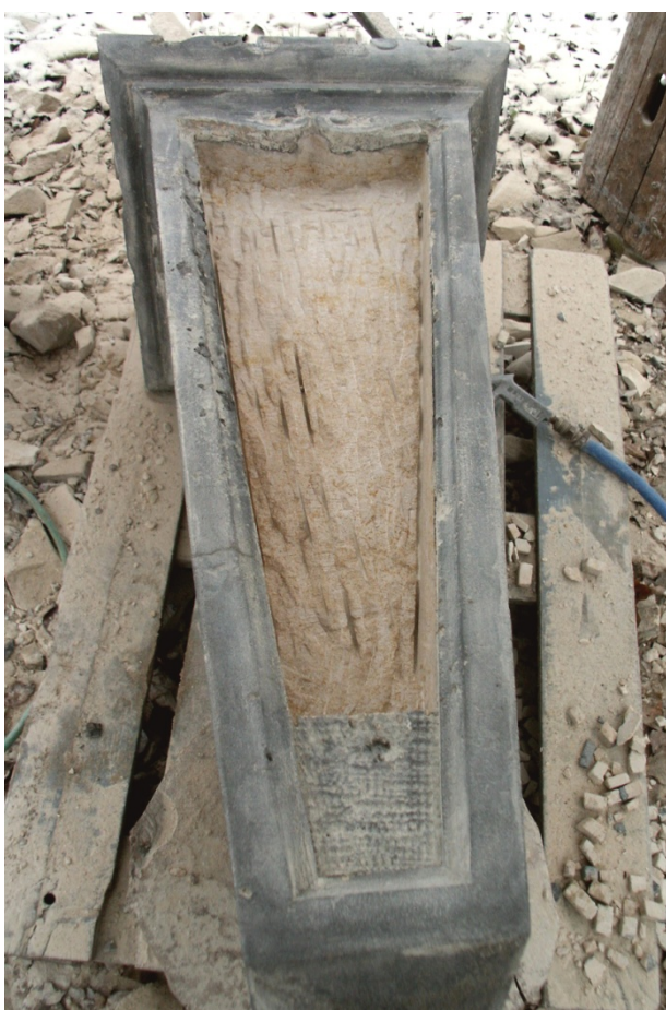
Fotodokumentace průběhu restaurování obelisku O11 v roce 2014 - Fotografie vlevo - příprava lůžka pro vsazení desky s kopií reliéfního rostlinného ornamentu. Fotografie vpravo - na nově vysekanou patku osazené originální tělo obelisku, se vsazenou nově vysekanou deskou s reliéfním rostlinným ornamentem.
