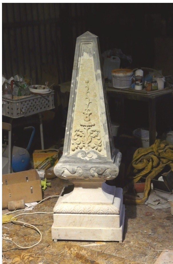
Fotodokumentace průběhu restaurování obelisku O11 v roce 2014 - Fotografie vlevo - příprava lůžka pro vsazení desky s kopií reliéfního rostlinného ornamentu. Fotografie vpravo - na nově vysekanou patku osazené originální tělo obelisku, se vsazenou nově vysekanou deskou s reliéfním rostlinným ornamentem.
