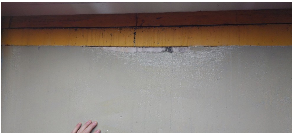
nesoudržná omítka ve vazbě na poškozený práh výtahových dveří ve výtahové šachtě IS811
