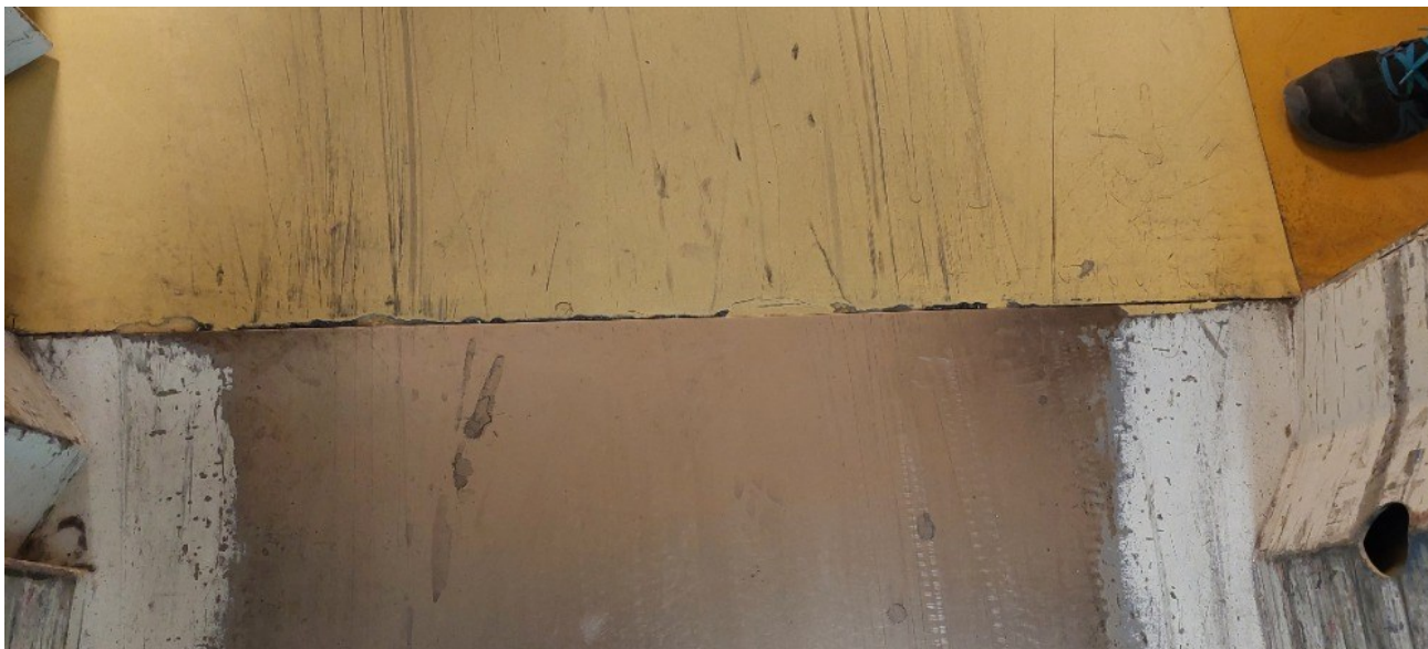
nesoudržná omítka ve vazbě na poškozený práh výtahových dveří ve výtahové šachtě IS811
