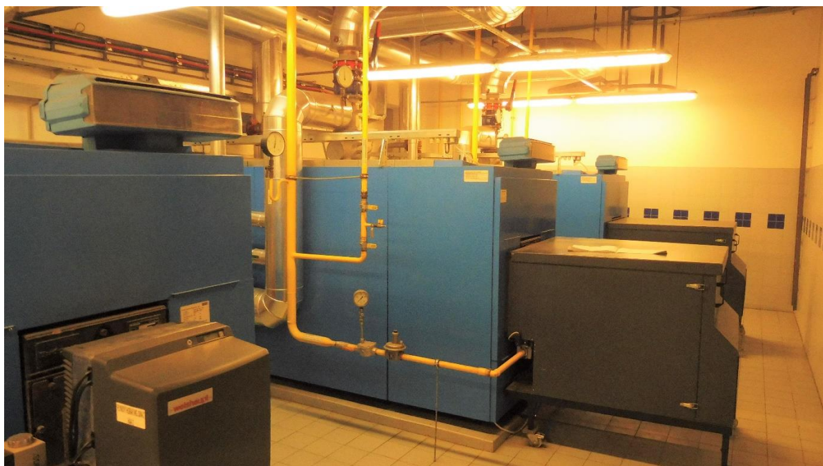
Obr. 1 Prostor stávající kotelně v místnosti 3S302B, kde je uvažováno s instalací kogenerační jednotky (foto Bres spol s r. o.)
