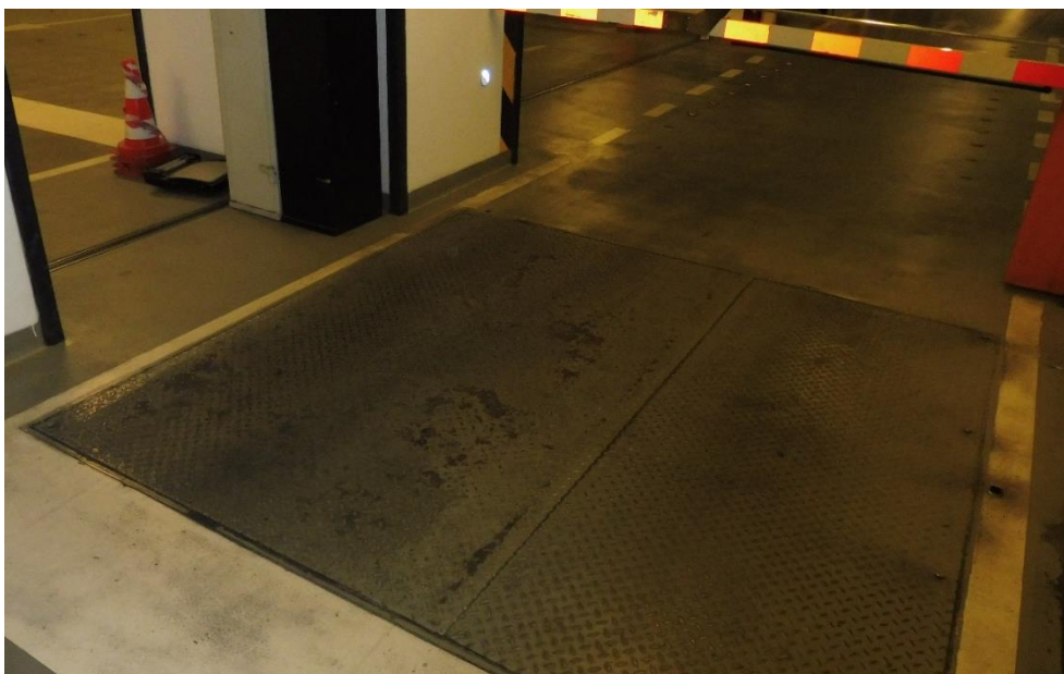
Obr. 6 Montážní otvor, kterým je možné dopravit zařízení do kotelny (foto Bres spol. s r. o.)
