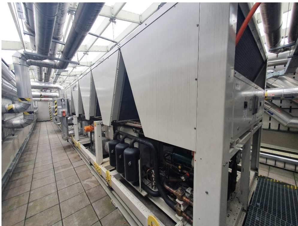
Obr. 2 Jednotky AERMEC NRB 2600 umístěné v prostoru 5P411 (foto Bres spol s r. o.)
