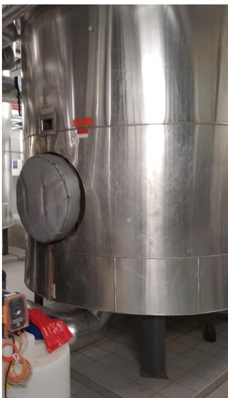
Obr. 13 Jediný ze tří původních zásobníku TV (10 m 3 ), označen jako zásobník č. 3, který je v současnosti používán (foto Bres spol. s r. o.)
