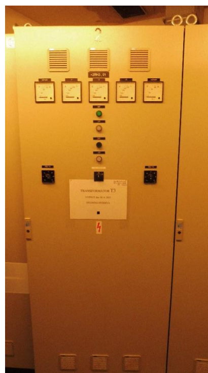
Obr. 14 Transformátorové pole 2RH3_01 sloužící k vyvedení elektrického výkonu (foto Bres spol. s r. o.)
