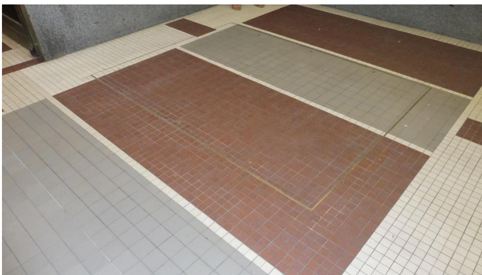
Obr. 7 Montážní otvor v pasáži (foto Bres spol. s r. o.)
