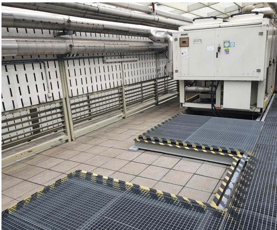
Obr. 3 Jednotka AERMEC NRB1400 včetně volného prostoru pro možné umístění další chladicí jednotky v prostoru 5P340 (foto Bres spol. s r. o.)
