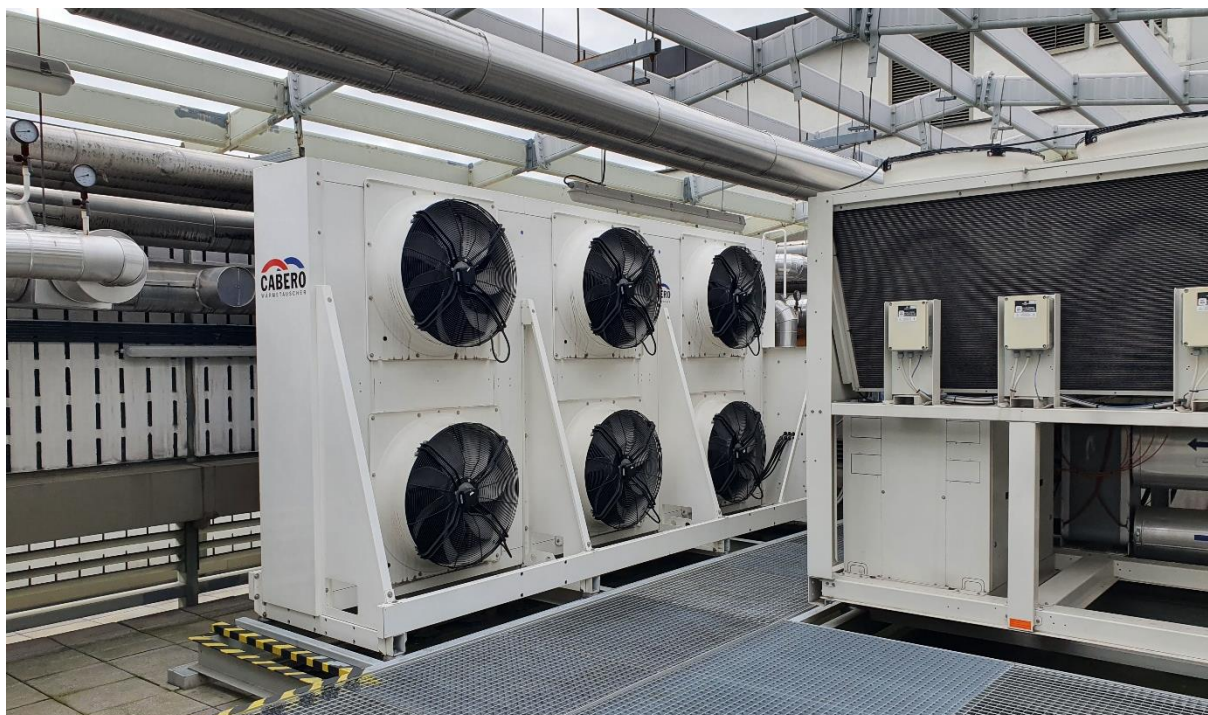
Obr. 4 Jednotka volného chlazení CABERO v prostoru 5P340 (foto Bres spol. s r. o.)
