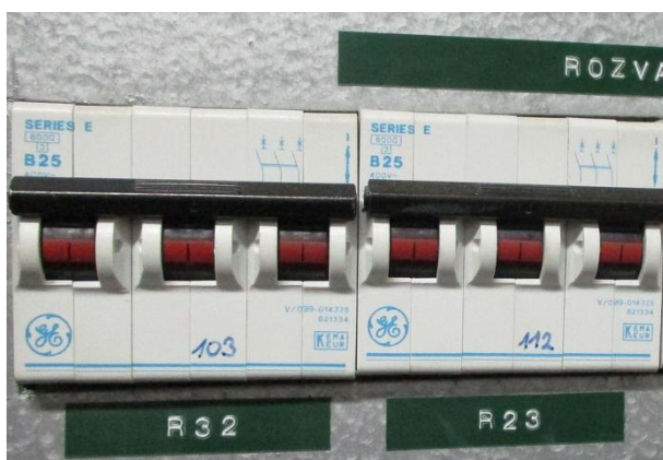
Obr. 6 – jističe se zkratovou odolností 6kA ve 3.poli rozváděče R05-SÍŤ
