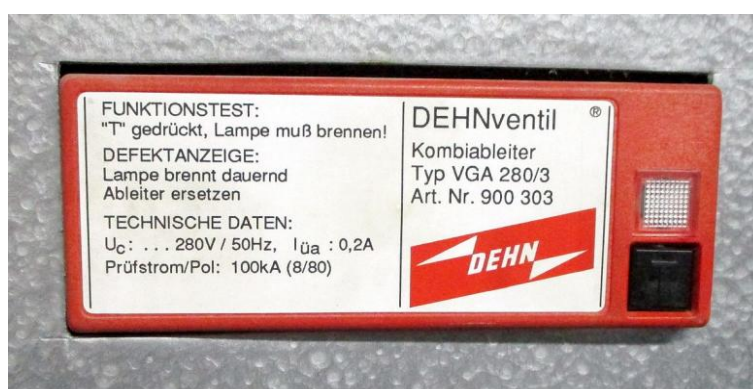
Obr. 3 – rozváděč R05-SÍT – 1.pole – přepět'ová ochrana
