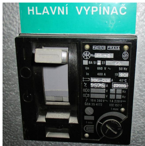
Obr. 7 – rozváděč R05-DIESEL – 1.pole - hlavní jistič rozváděče
