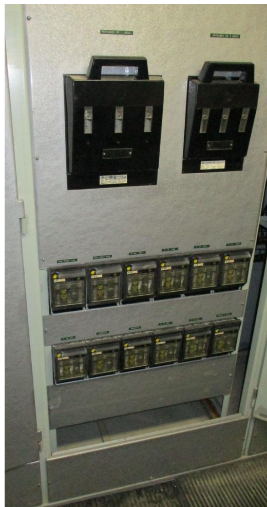
Obr. 2 – rozváděč R05-SÍT – 2.pole
