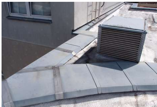
Náhled na nadstřešní vyústění VZT:
